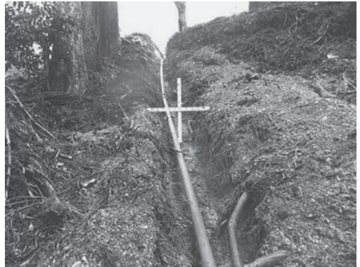
図26 送水管・掘削
