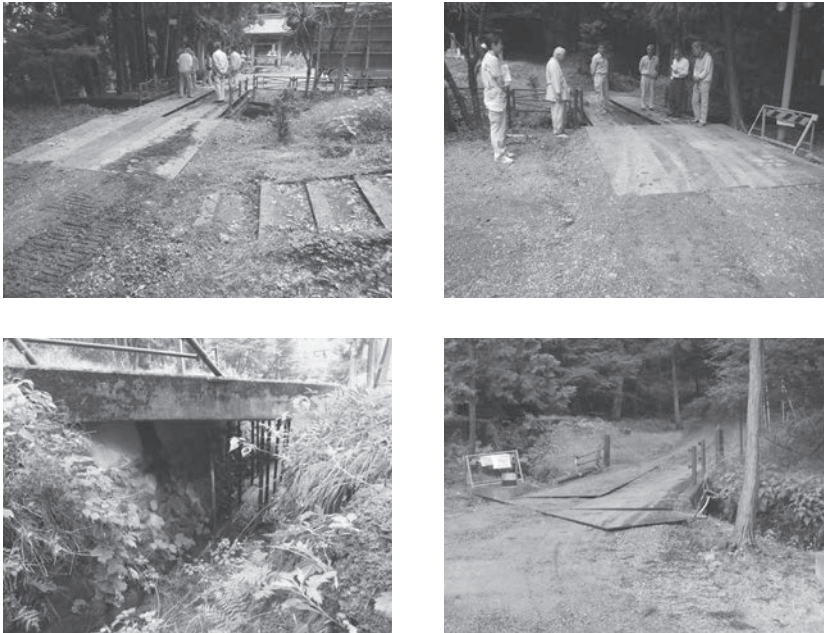
図18 橋の補強（資材運搬経路） 鋼板敷きは自立させ、橋に負担をかけない構造にしている
