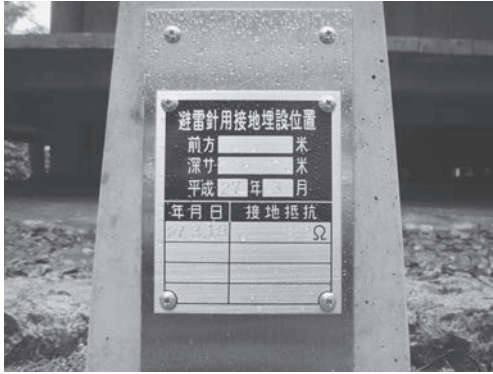
図35 避雷設備基礎（竣工）
