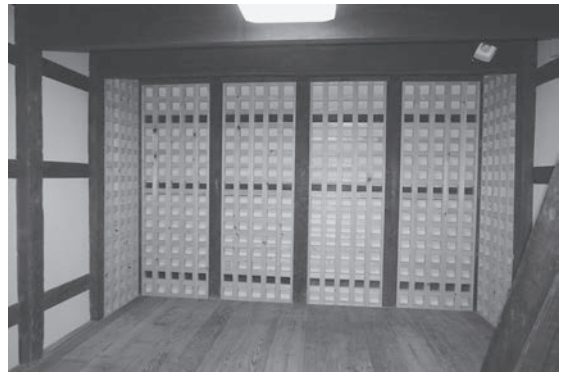
図20 一階面格子壁設置状況
