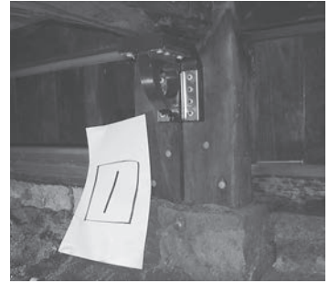
図18 柱と大引の仕口に耐震リングを取り付けた状態
