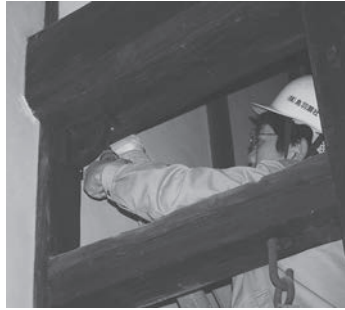
図17 通りニワの柱と梁の仕口に耐震リングを取り付けた状態
