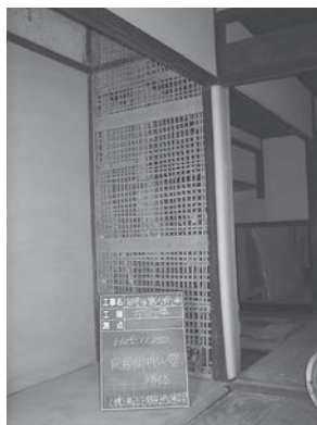
図12 土壁の解体状況 （小舞下地）
