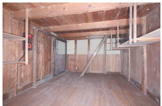
図28 土蔵1 竣工 1階 (東側から西側を見る)
