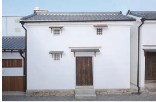
図30 土蔵3 竣工 正面
