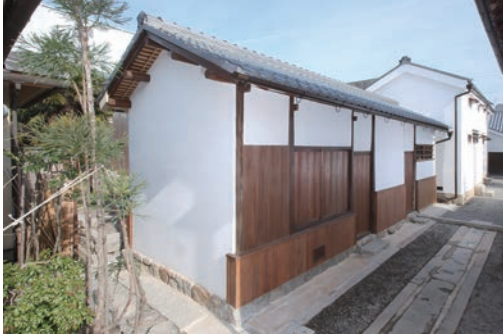
図23 長屋 竣工 正面
