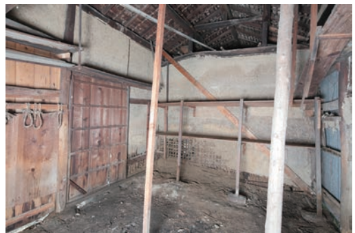
図6 長屋 修理前 物入 (東側から西側を見る)
