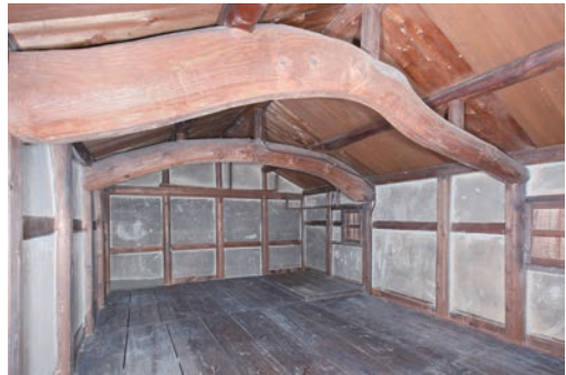
図32 土蔵3 竣工 2階 (西側から東側を見る)
