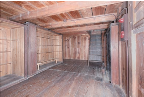
図31 土蔵3 竣工 1階 (西側から東側を見る)
