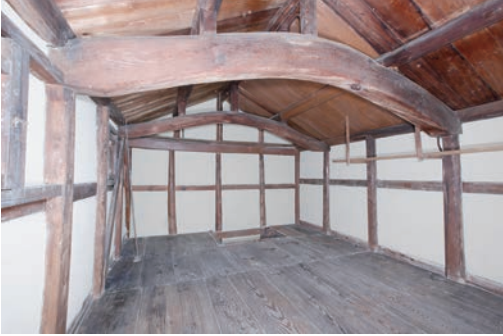
図29 土蔵1 竣工 2階 (東側から西側を見る)
