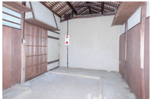
図26 長屋 竣工 物入 (東側から西側を見る)
