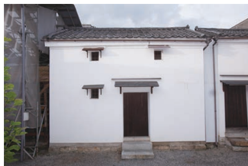
図10 土蔵3 修理前 正面
