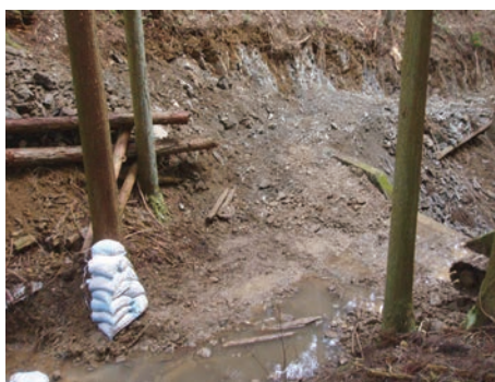
写真2 工事前の堰堤(上流側より)
