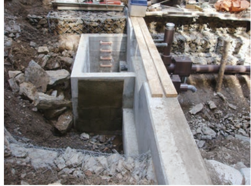
写真4 ピット通水マット
