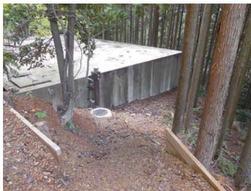
写真10 貯水槽空気弁
