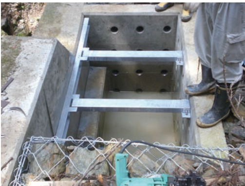
写真5 ピット通水孔
