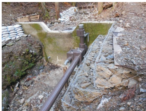
写真8 堰堤導水管
