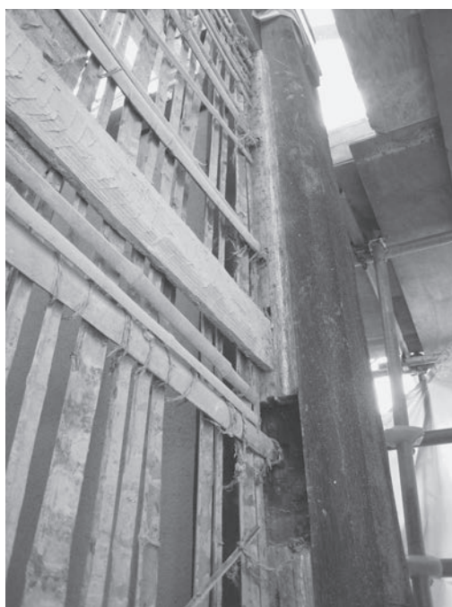
図16 北西隅柱の楣の痕跡
