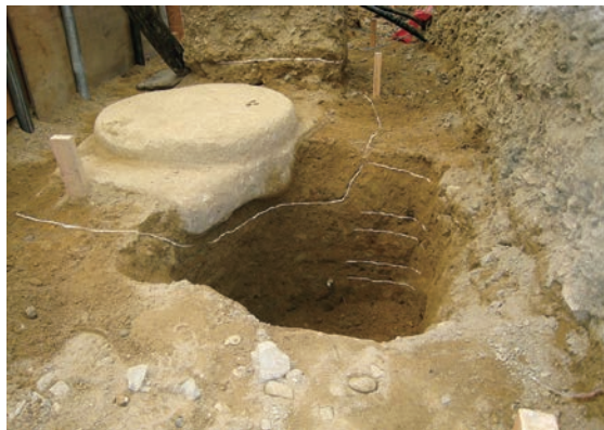
図7 発見された柱礎石廻りの試掘状況
