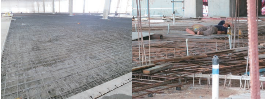
スライド3 プロジェクト3（左）とプロジェクト4（右）の現場の鉄筋組立写真
