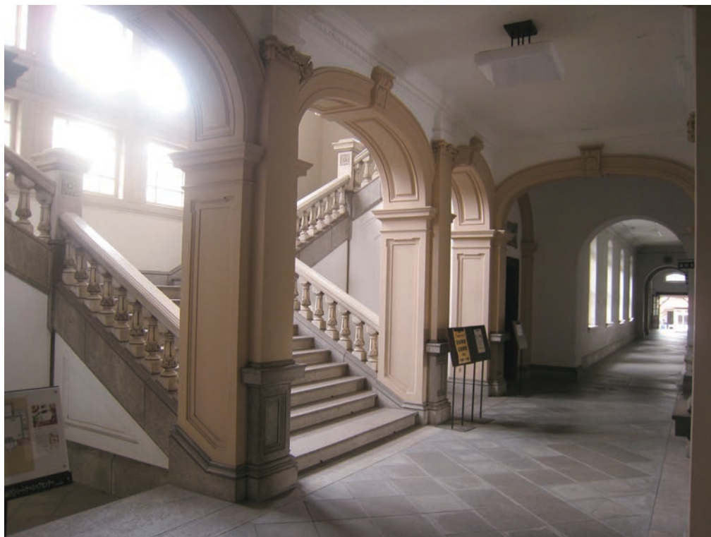
写真1 正面階段付近
