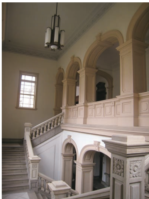
写真2 正面階段踊場から2階を見る
