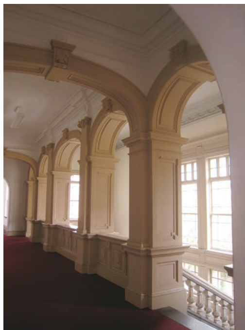
写真3 2階正庁前廊下から正面階段を見る
