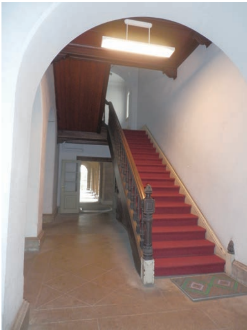
写真5 北階段東を1階から見る
