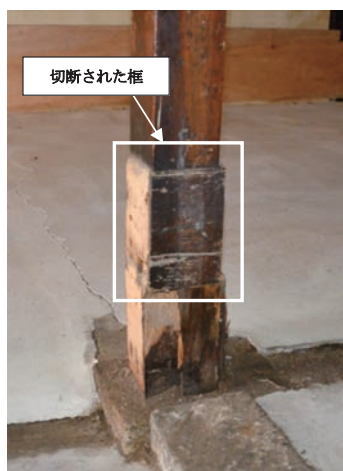
図6 「ろ」通「七」柱下部
