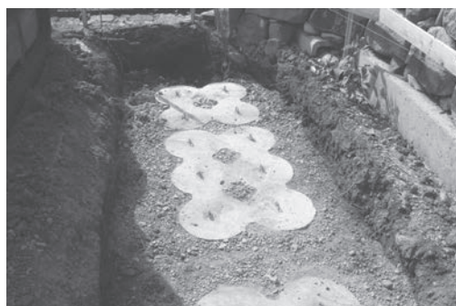
図9 コマ型コンクリートブロック敷設
