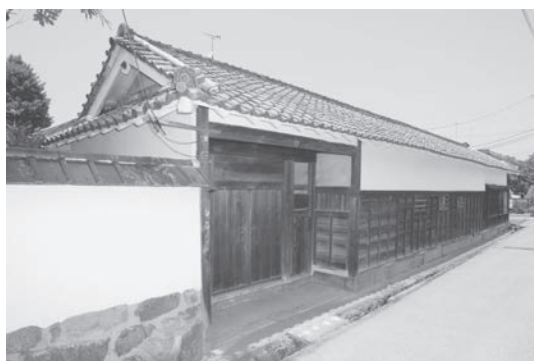
図3 修理前 正面（東面）
