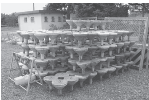
図8 コマ型コンクリートブロック搬入
