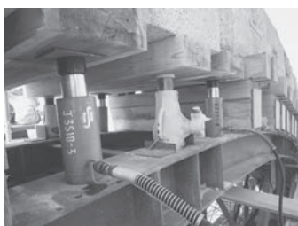
写真-7 油圧ジャッキ設置状況
