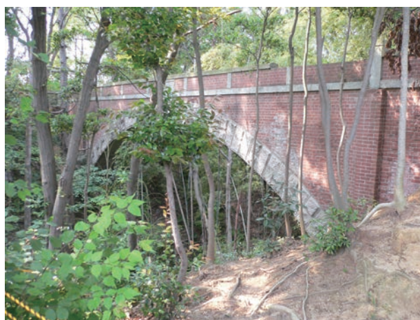
写真-1 移設前の状況（平成18年6月撮影）
