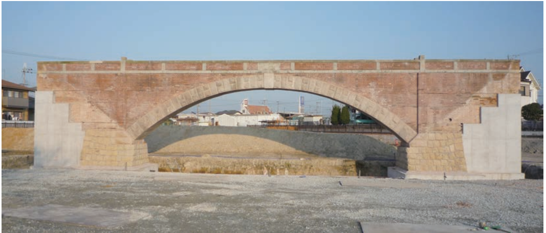
写真-15 構築完了
