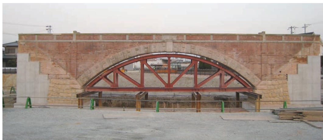
写真-11 煉瓦壁設置完了（下流側）
