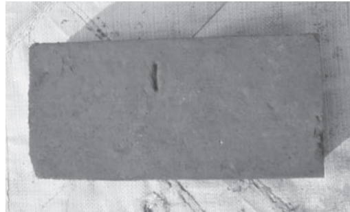
写真-16 煉瓦面に残る刻印
