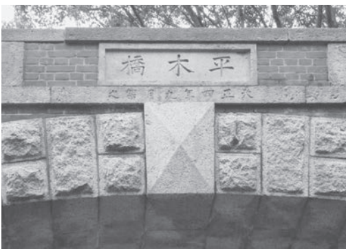
写真-2 上流側の額石と地覆石の陰刻
