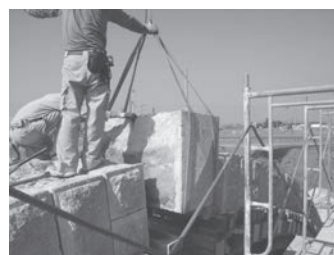
写真-8 要石取外し状況
