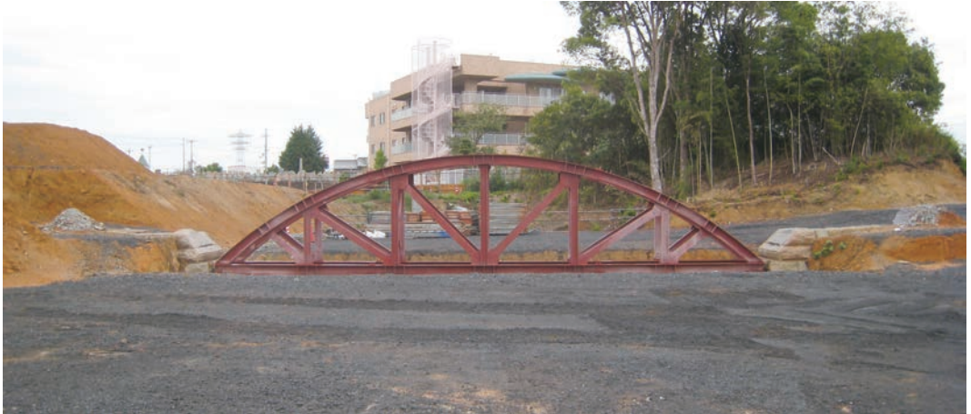
写真-9 要石・輪石解体完了（下流側）
