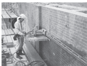
写真-6 煉瓦壁切断状況
