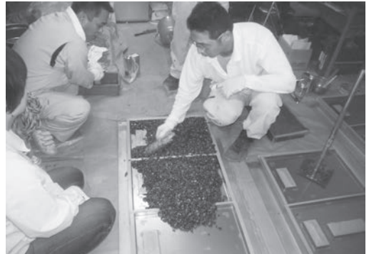
写真-26 ステンレス蓋箱に敷き均し
