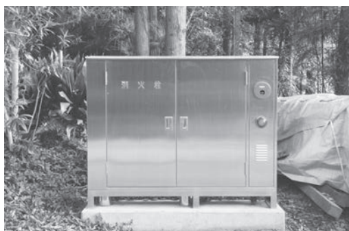
写真-13 ユニット型消火栓（外観）
