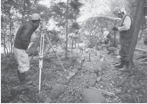
写真-23 御茶屋庭園 測量作業
