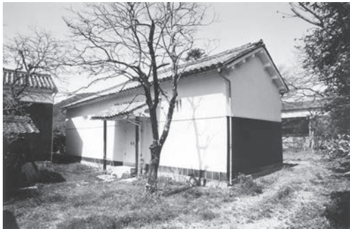
図25 米蔵（南東より） 修理前
