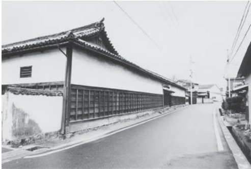
図17 長屋 修理前（南東より）
