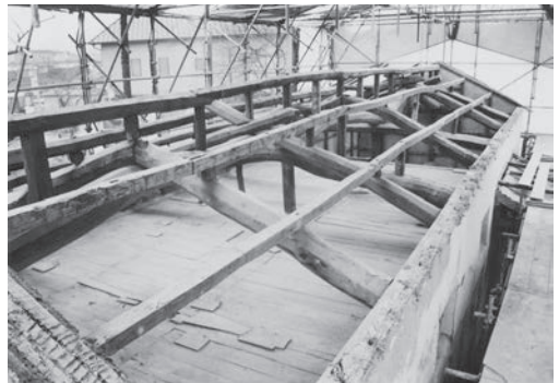
図29 米蔵 小屋組（南西より）
