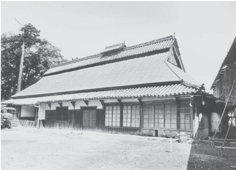
図2 主屋修理前（南東より）
