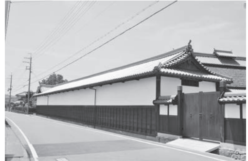
図18 同左 竣工（北東より）
