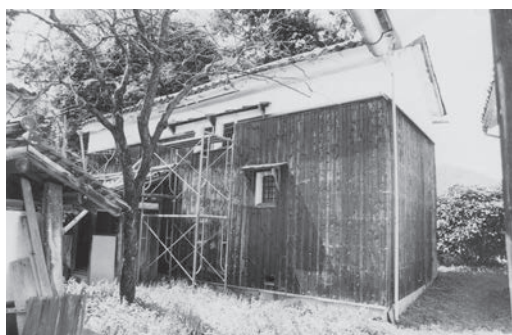
図21 内蔵（北東より）修理前
