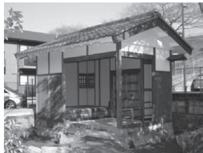
図20 竣工後 乾門 南東面から内部を見る
