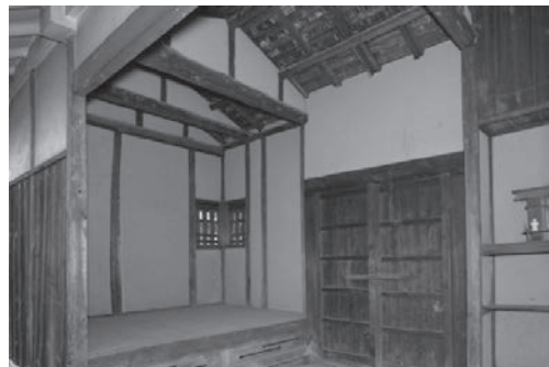
図14 修理前 乾門 内部北西面
