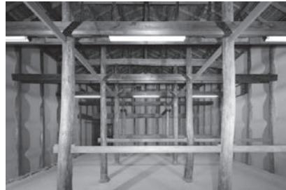
図18 竣工後 物入2 内部西面
