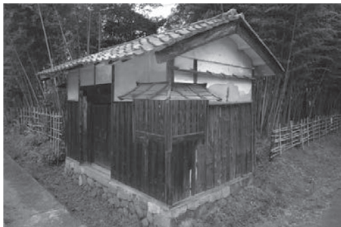
図13 修理前 乾門 正側面（北西面）
