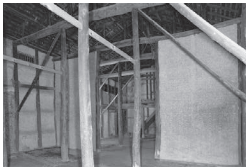
図7 修理前 物入2 内部南西面
