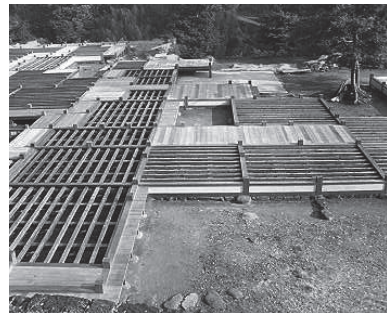
図9 床組の組立中
