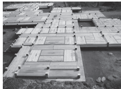
図10 床組の組立中
