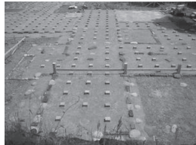
図8 礎石、束石の据付状況
