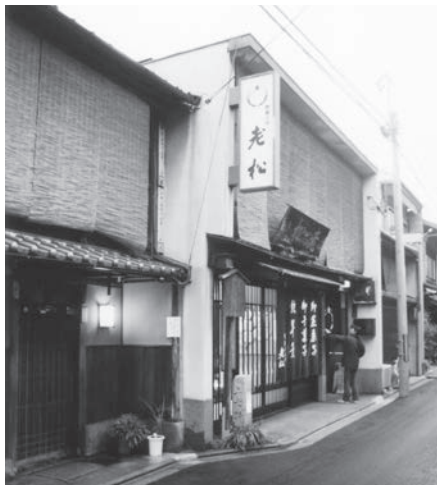
図2 改修前ファサード
