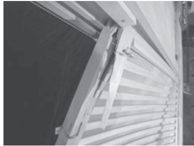
図14 縦棧の割裂 (試験体C-1/20rad)
