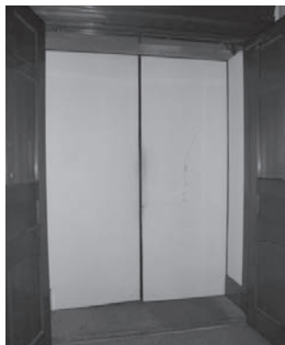
写真 3.10 1階古文書室・書庫境鋼製防火扉の裏面 (2階から移設)
