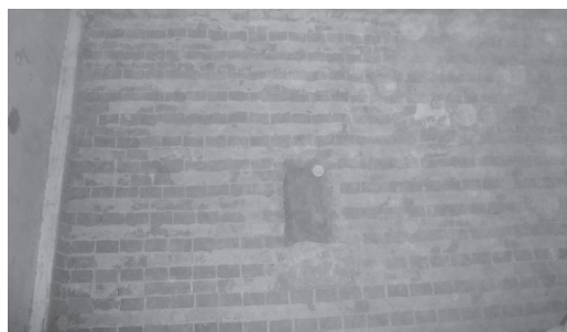
写真 3.9 階段脇壁の階段側桁受け
