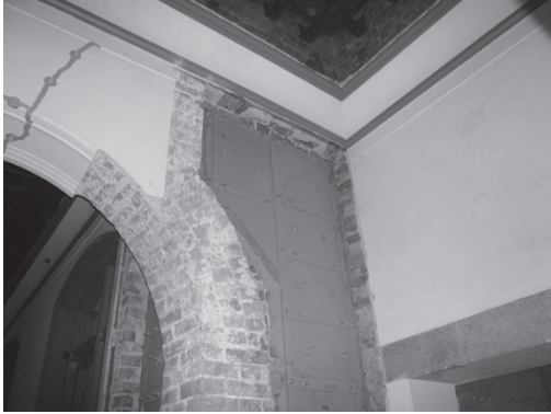
写真 3.4 廊下仕切アーチ
