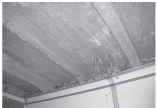
写真 3.7 鉄筋コンクリート梁 (大正12年建築部分)
