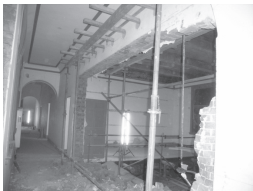
写真 2.3 便所整備、廊下間仕切開口
