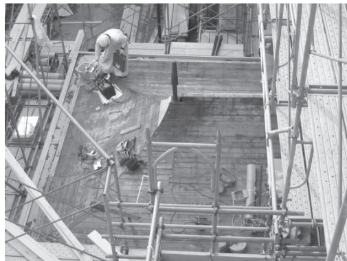
写真 2.2 玄関ポーチ銅板撤去
