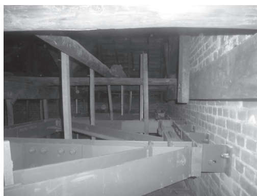
写真 4.4 鉄骨水平ブレース取付詳細
