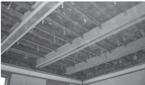
写真 3.6 昭和時代に2階床組鉄骨補強 (大正3年建築部分)
