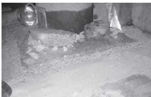
写真4 礎石廻り防蟻処理完了
