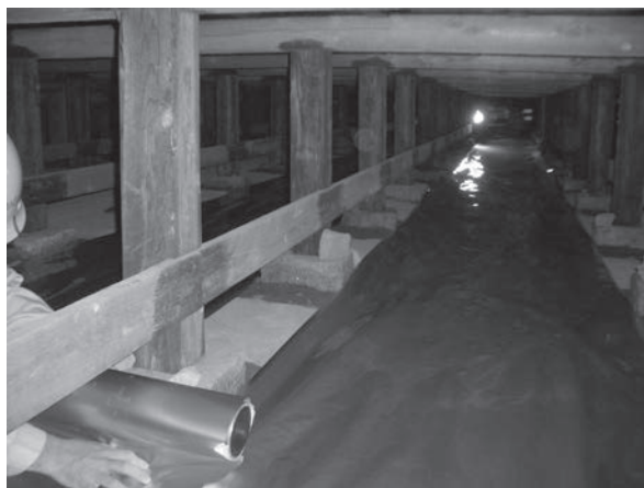
写真1 防蟻シート敷込作業
