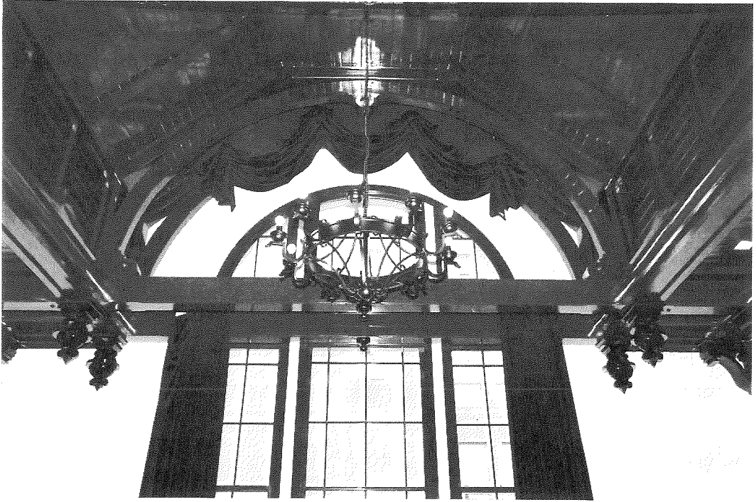
写真4. 2階講堂兼礼拝堂 東・西窓遮光カーテン
