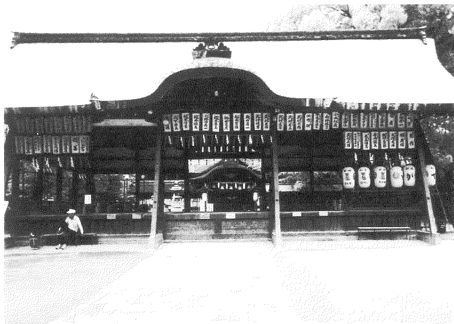
写真－1 （整備前）各柱に控柱が見られる
