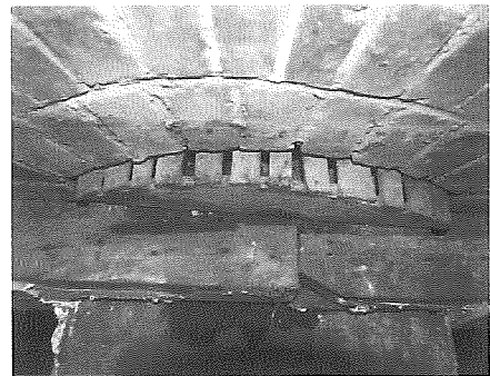
写7 アーチ型枠（2階床梁受）
