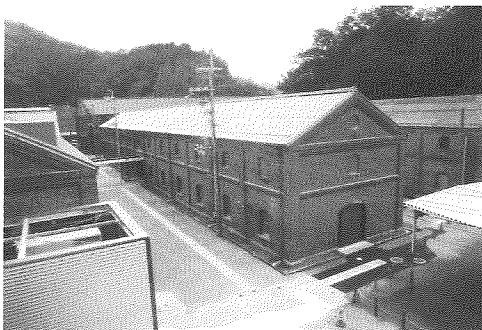
写11 竣工 北東から臨む
