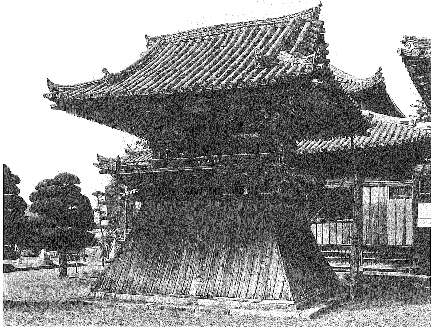
写真-2 解体前の状況（北東から見る）
