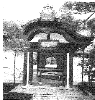
図2 修理前玄関廊正面（西より）
