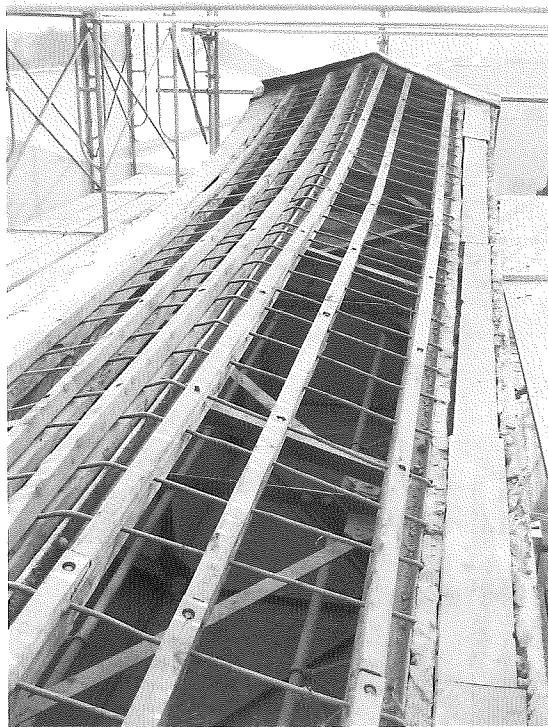
写真-2 大鳥居筈木屋根内部
