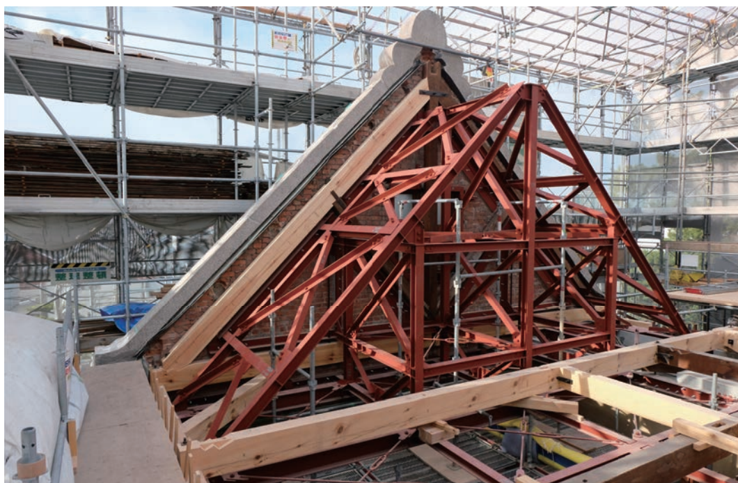
写真15 洋館 北妻壁 鉄骨補強（南西より見る）
