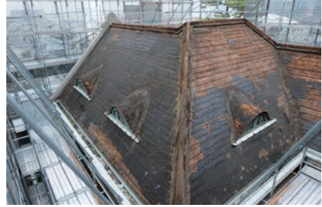
写真7 洋館 当初屋根下地 (南西より見る)
