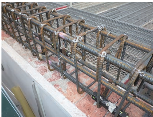
写真16 洋館 煉瓦壁上部 臥梁配筋状況
