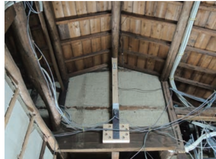
写真18 和館 柱折損防止のための補強
