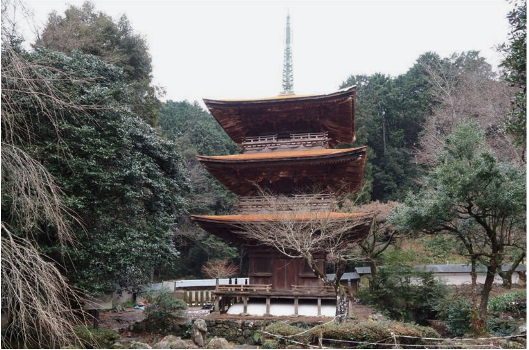
口絵9 竣工 滋賀県指定有形文化財徳源院三重塔 東面を見る
