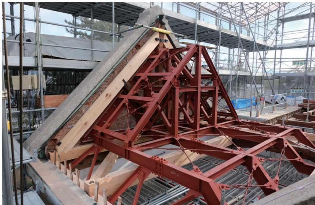
写真14 洋館 南妻壁 鉄骨補強（北東より見る）
