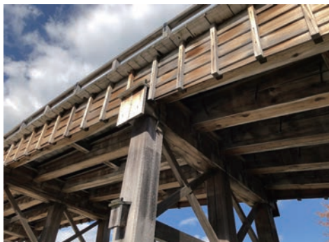
写真15-9 木製橋脚の木口を覆う板（錦帯橋）
