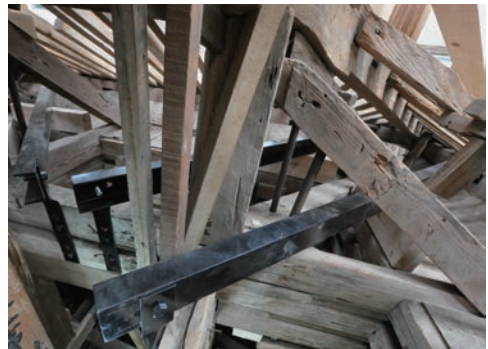
図5 3層小屋組に丸桁桔木取付け。 内部は通し肘木に固定。
