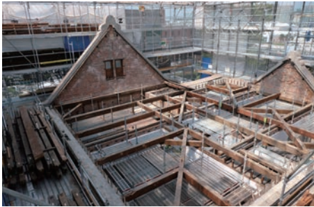
写真8 洋館 小屋組解体完了 (南西より見る)
