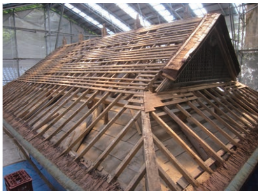
図3 野木舞取替え状況
