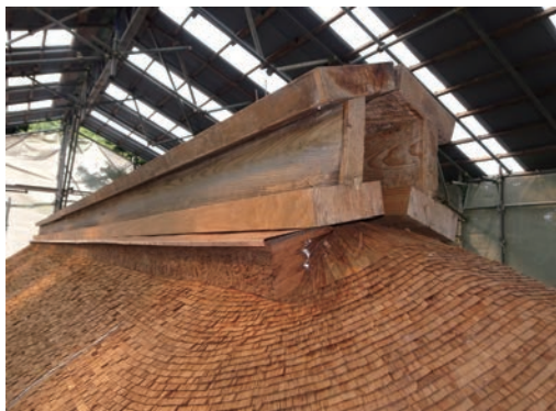
図6 箱棟取付け状況 障泥板は取替え、その他は再用。
