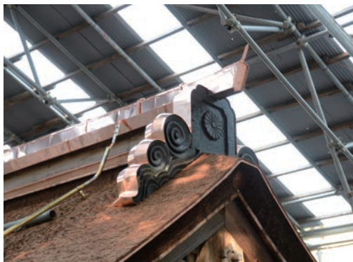
図7 竣工 鬼板新調、上端のみ銅板巻き
