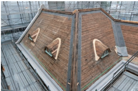
写真10 洋館 屋根下地組立完了 (南西より見る)
