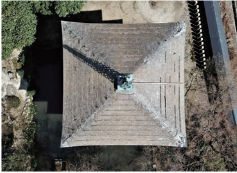
図2 修理前 空撮（右：南）
