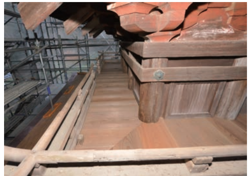
図7 竣工 2層縁 仮設的に高欄内側に縁板を張る。
