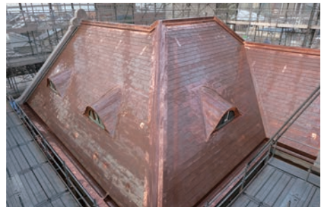
写真11 洋館 銅板葺完了 (南西より見る)
