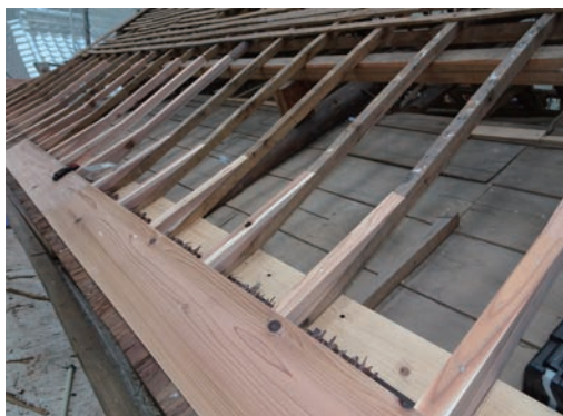
図4 軒付廻り調整状況 鼻母屋を下げて軒付廻りの落込みを確保する。
